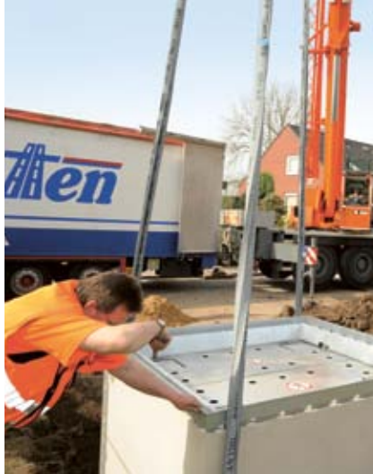
■ ... werden die Betonschächte millimetergenau eingepasst, ...
