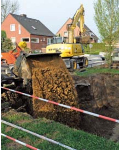
■ Making-of Unterflur: Nach Fertigstellung der Baugrube ...
